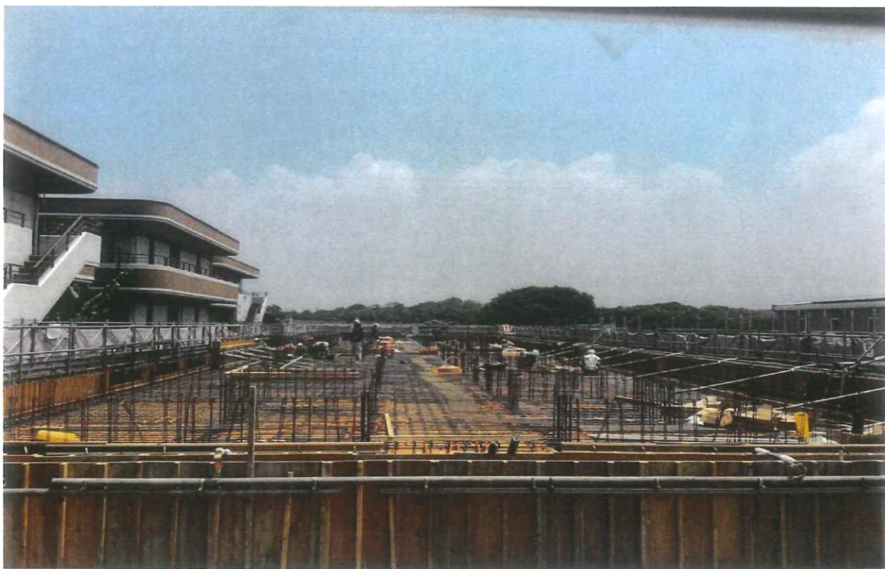
増床建物鉄筋組立、型枠工事（市道側から東側を撮影）
