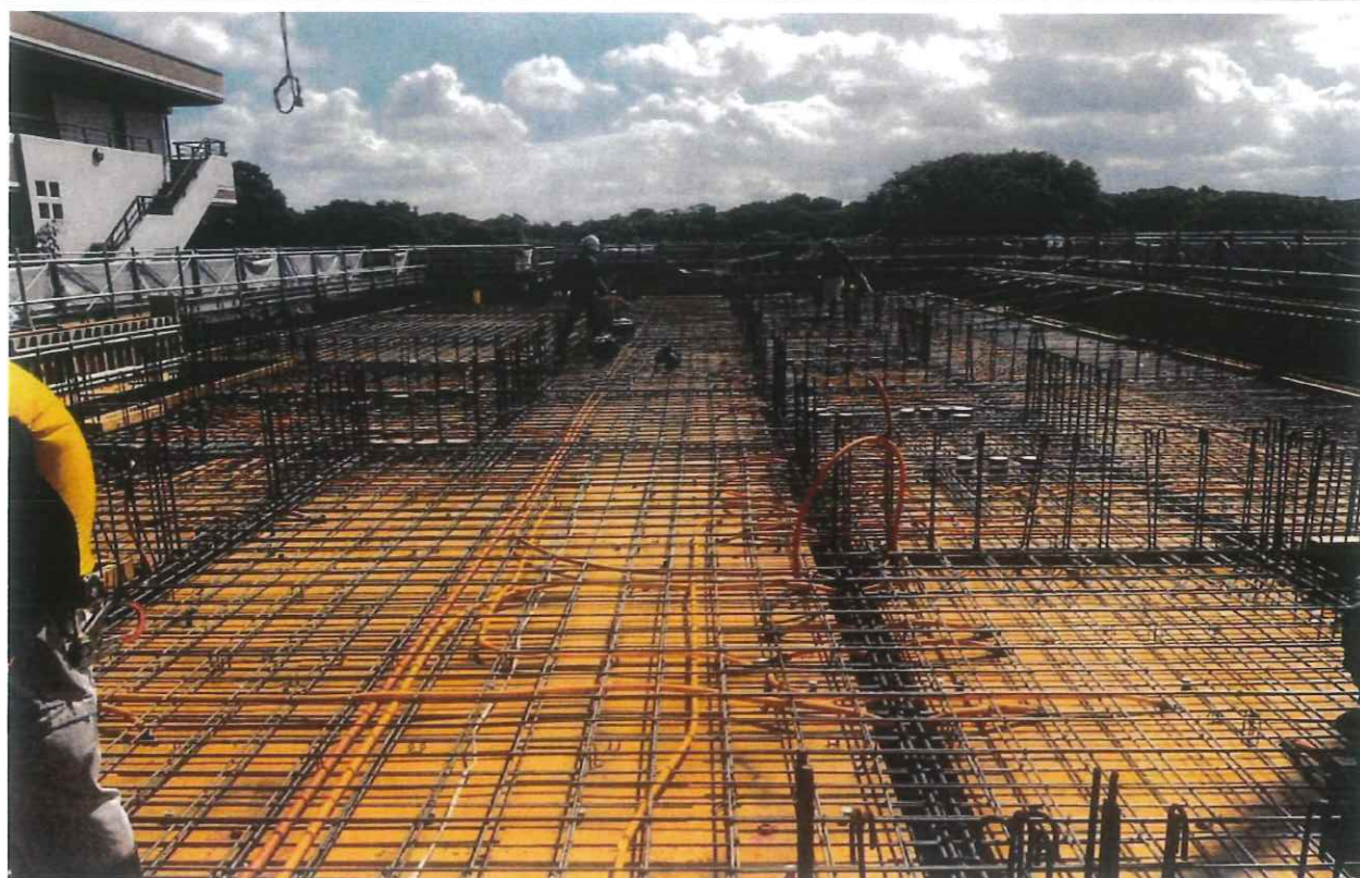
工事近影①
